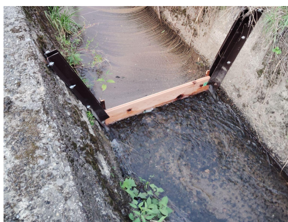
(写真 6) 設置を行ったアングル及び堰き止め板
